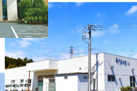
新日本工芸(株) 水戸本社
